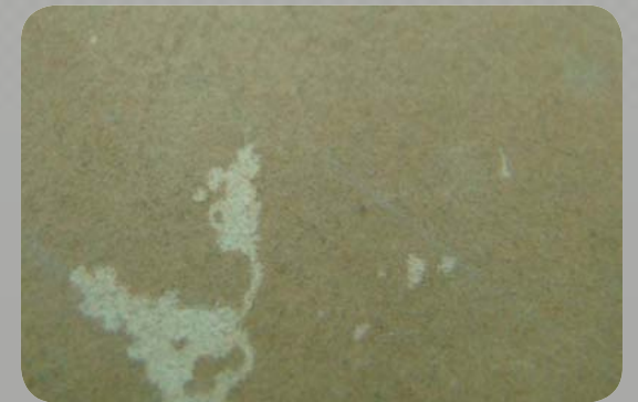
Typische graasschade door zilvervisje. Foto: Guy De Witte
